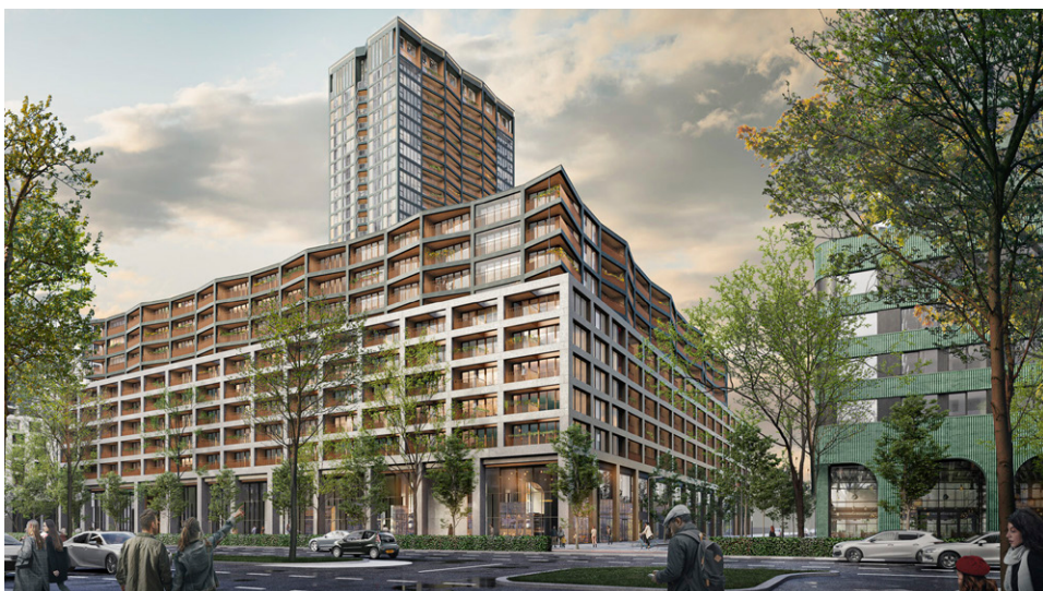
Beeld: Voor het project BoogieWood (ontwerp: De Zwarte Hond en OZ) wordt een bestaand kantoorgebouw getransformeerd naar een woongebouw met sociale en middenhuur. De parkeergarage vormt de fundering. De opbouw wordt van hout (Cross laminated Timber). BoogieWood won de Gouden Hijskraan 2025, vanwege de bijzondere, gezamenlijke inspanning die door alle partijen is geleverd om de bouw te versnellen.
